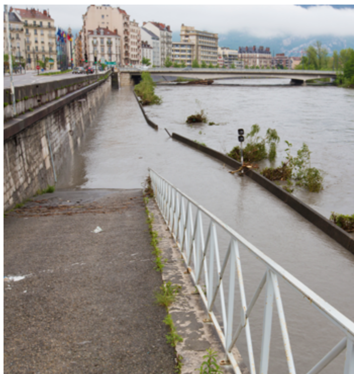
Isère en crue décennale et inondation des quais de France
